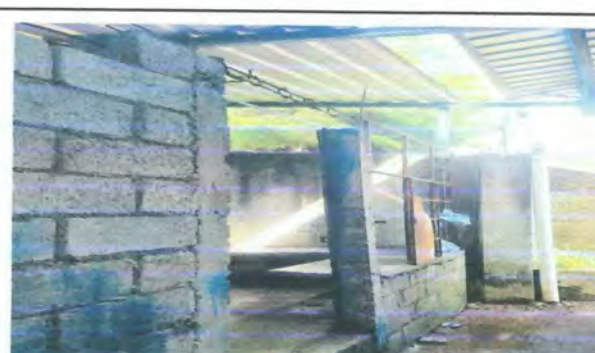
Foto 6: Remozamiento en área de cocina con agregado de block en paredes para formalizar la estructura y repellado de las paredes.
